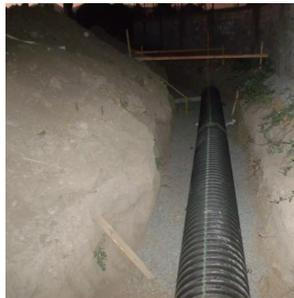
El Proyecto contempló la Provisión e Instalación de Tuberías de HDP de 600 mm., cámaras de inspección con la finalidad de dar solución a la evacuación de aguas lluvias en la Población San Pedro, Esperanza y Reconquista, las que año a año sufrieron anegamientos de Vías Públicas y Propiedades.
