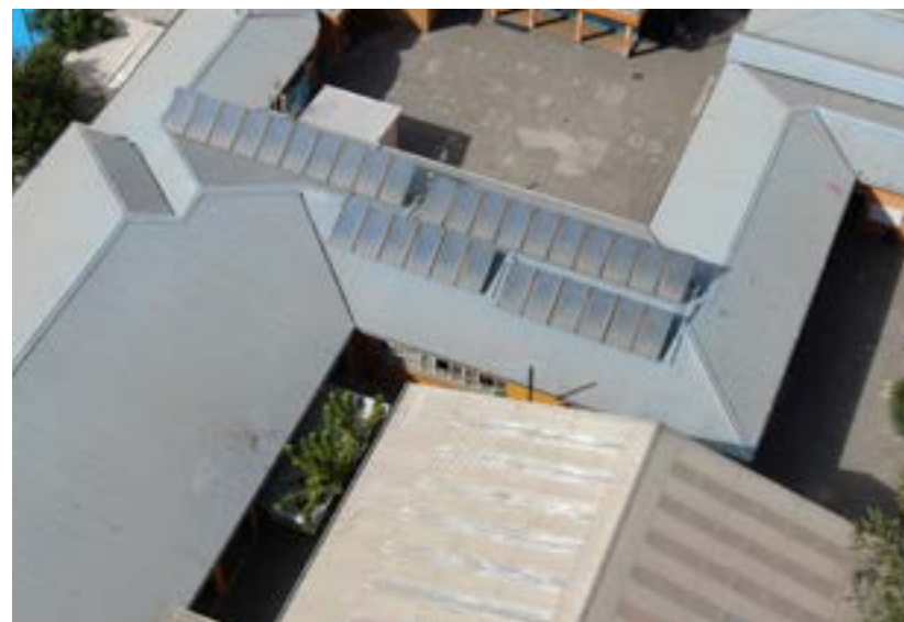
Instalación paneles solares Colegio Moisés Mussa
