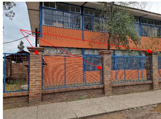
Fotografía N° 42 – Colegio René Shneider – Deficiente terminación de pintura en cierre perimetral.
