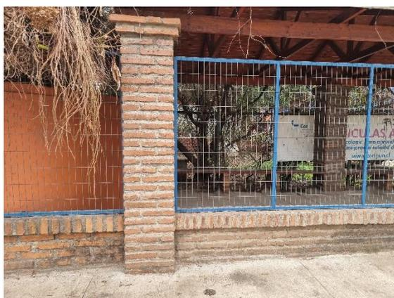
Fotografía N° 43 – Colegio René Shneider – Deficiente terminación de pintura en cierre perimetral.
