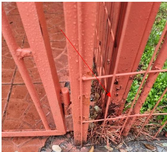
Fotografía N° 15 - Colegio España - Falta de preparación de superficie.
