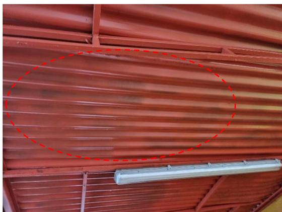
Fotografía N° 17 - Colegio España – Deficiente terminación y falta de cobertura.
