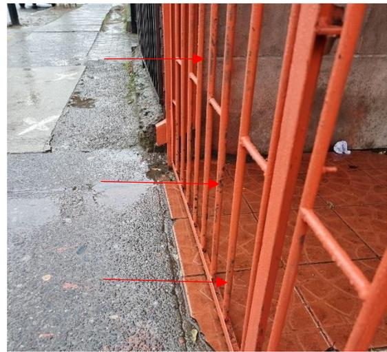
Fotografía N° 16 - Colegio España - Falta de preparación de superficie.
