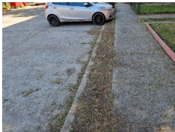
Fotografía N°77 - Norte ID19 - 27/10/2021 Falta de limpieza veredas y cunetas.
