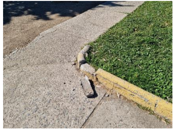
Fotografía N°20 - Damero ID273 - 25/10/2021 Solerillas quebradas y desprendidas.
