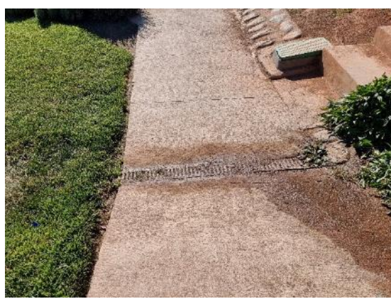
Fotografía N°13 - Damero ID1624 - 25/10/2021 Falta de limpieza y desmalezamiento canaleta.
