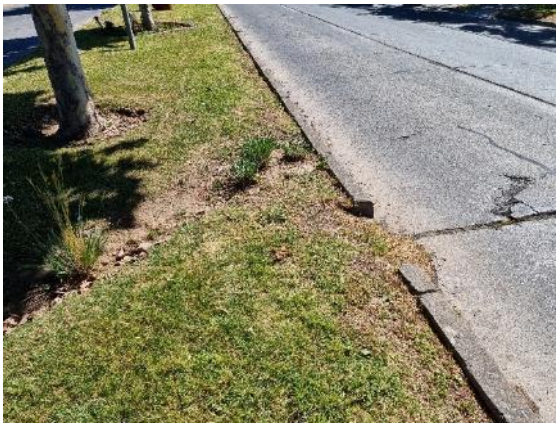
Fotografía N°27 - Damero ID1328 - 25/10/2021 Falta de soleras.
