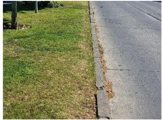
Fotografía N°26 - Damero ID1328 - 25/10/2021 Falta de limpieza cunetas.
