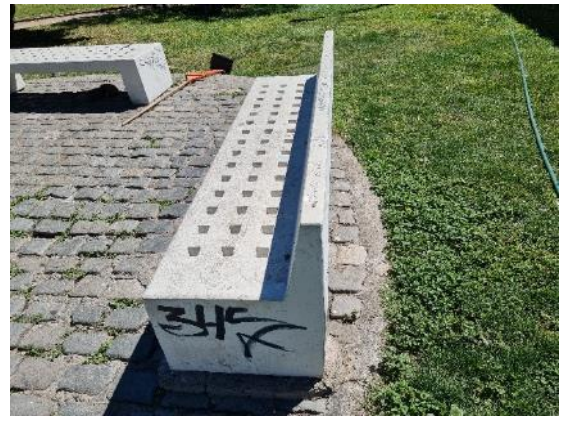
Fotografía N°40 - Damero ID579 - 25/10/2021 Falta limpieza grafitis.
