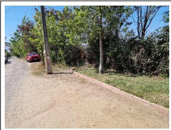
Fotografía N°97 – Sur ID1302 – 27/10/2021 Espesor de maicillo insuficiente.
