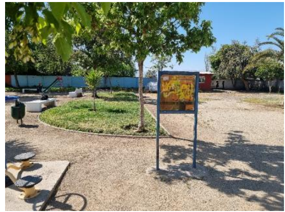
Fotografía N°94 – Sur ID282 – 27/10/2021 Falta limpieza de grafitis.
