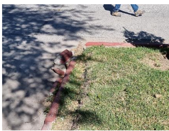
Fotografía N°19 - Damero ID273 - 25/10/2021 Solerillas quebradas y desprendidas.
