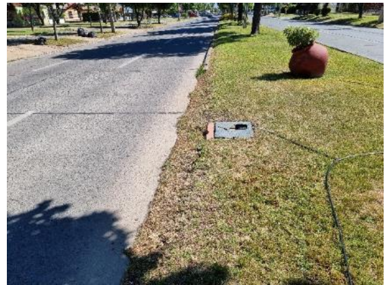
Fotografía N°28 - Damero ID1328 - 25/10/2021 Falta de soleras.
