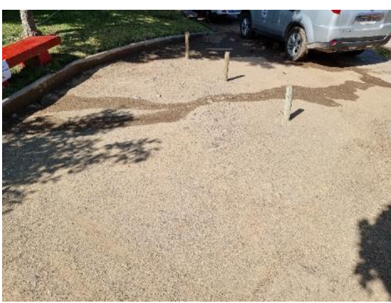
Fotografía N°85 – Sur ID282 – 27/10/2021 Deficiente espesor de maicillo.
