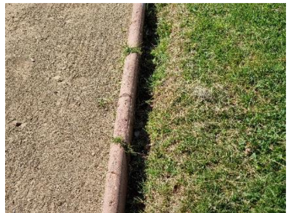
Fotografía N°96 – Sur ID1302 – 27/10/2021 Falta desmalezado en solerillas.
