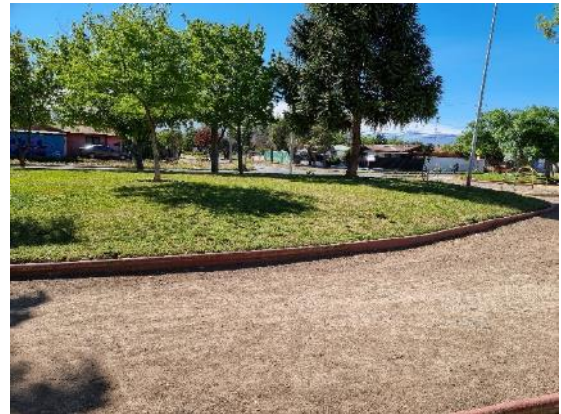
Fotografía N°14 - Damero ID273 - 25/10/2021 Falta de maicillo.
