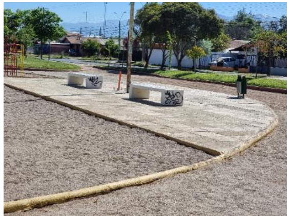
Fotografía N°21 - Damero ID273 - 25/10/2021 Falta de limpieza grafitis.
