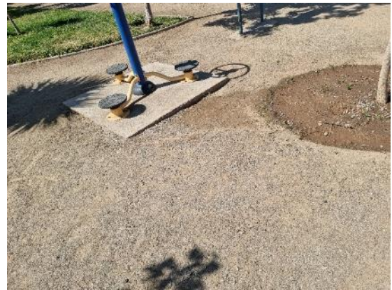
Fotografía N°88 – Sur ID282 – 27/10/2021 Falta Maicillo.
