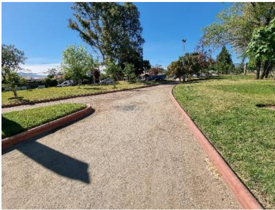
Fotografía N°15 - Damero ID273 - 25/10/2021 Falta de maicillo.
