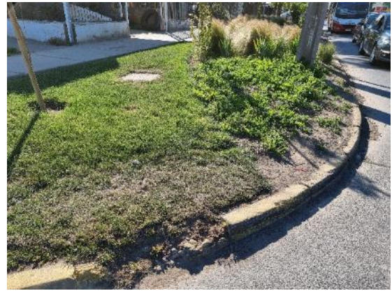
Fotografía N°8 - Damero ID1643 - 25/10/2021 Soleras quebradas y faltantes.
