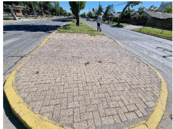
Fotografía N°22 - Damero ID1328 - 25/10/2021 Maleza sector adoquines y solera.
