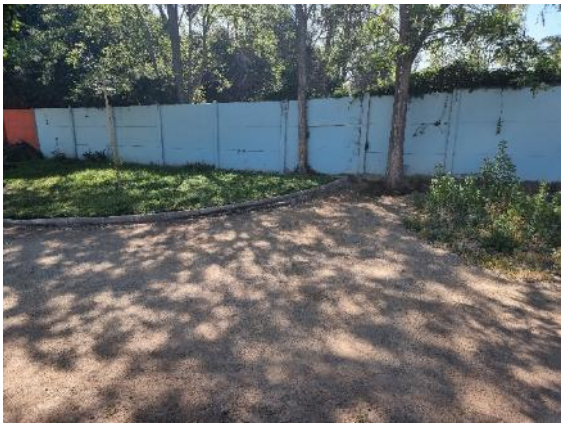
Fotografía N°87 – Sur ID380 – 27/10/2021 Falta de maicillo.
