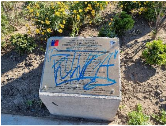
Fotografía N°7 - Damero ID1643 - 25/10/2021 Falta de limpieza grafitis.
