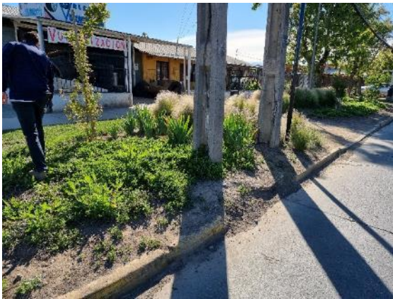
Fotografía N°9 - Damero ID1643 - 25/10/2021 Soleras quebradas y faltantes.
