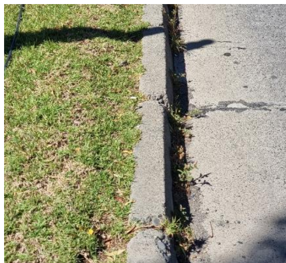
Fotografía N°23 - Damero ID1328 - 25/10/2021 Maleza sector adoquines y solera.
