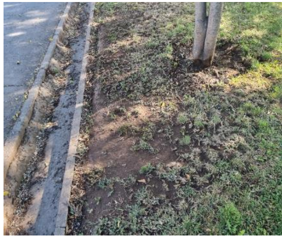
Fotografía N°75 - Norte ID43 - 27/10/2021 Falta de limpieza de cunetas.
