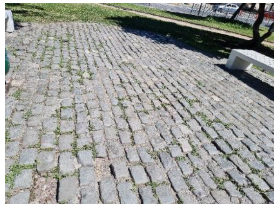
Fotografía N°42 - Damero ID579 - 25/10/2021 Falta desmalezado.
