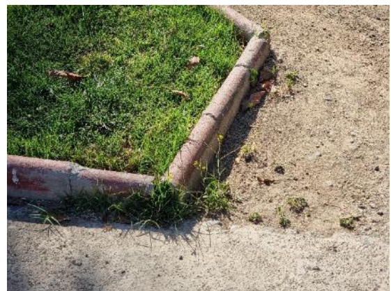
Fotografía N°78 - Norte ID19 - 27/10/2021 Falta de limpieza veredas y cunetas.
