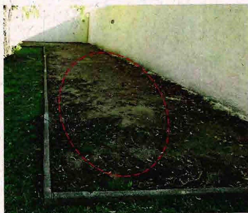
Fotografía N°54 -"Diseño y construcción de áreas verdes en la comuna de Rancagua" – OT N°36 "Mejoramiento áreas verdes villa Pueblos Naturales": Deficiente aplicación de maicillo.
