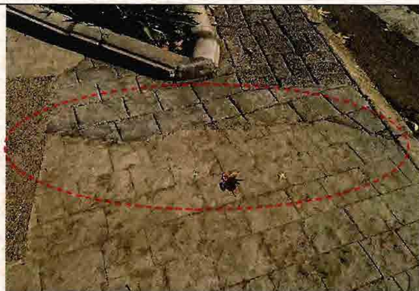
Fotografía N°36 - "Diseño y construcción de áreas verdes en la comuna de Rancagua" – OT N°1 "Mejoramiento bandejón lateral avenida Cachapoal": Deficiente reparación de pavimento.
