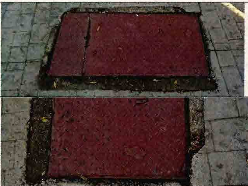
Fotografía N°39 - "Diseño y const. de áreas verdes en la comuna de Rgua" – OT N°12 "Mejoramiento espacio público, media luna monumental": Deficiente terminación de pavimento con cámaras.
