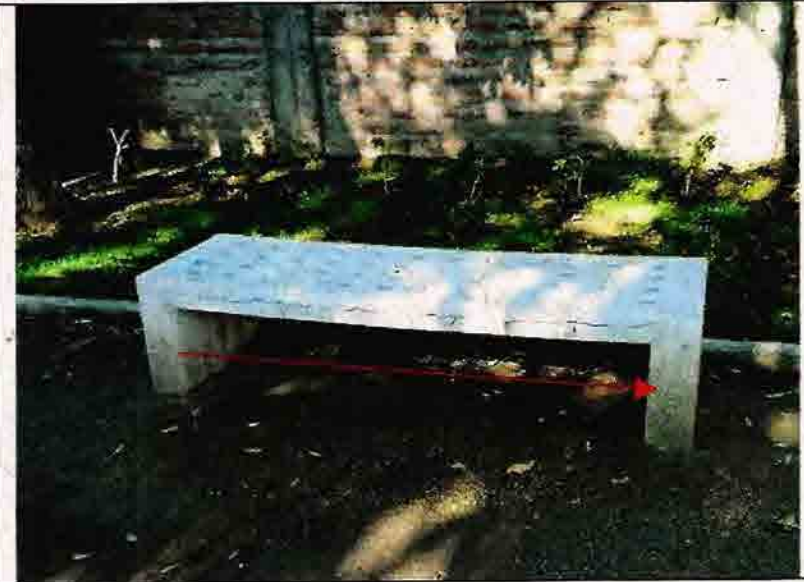
Fotografía N°44 - "Diseño y const. de áreas verdes en la comuna de Rgua" – OT N°6 "Provisión e instalación de escaños y basureros en diversos puntos de la comuna": Escaños con fisuras.
