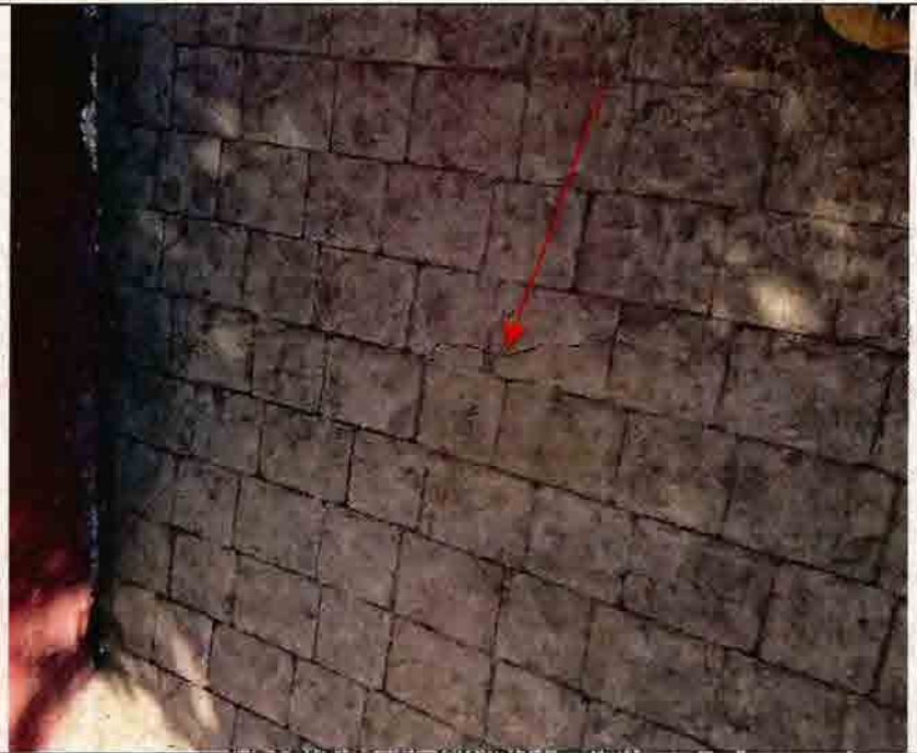
Fotografía N°4 – “Diseño y construcción de áreas verdes en la comuna de Rancagua” – OT N°1 “Mejoramiento bandejón lateral avenida Cachapoal”: Fisura en pavimento
