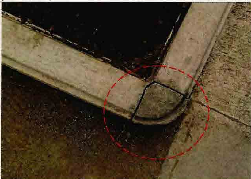
Fotografía N°27 -“Diseño y construcción de áreas verdes en la comuna de Rgua.” – OT N°43 “Mejoramiento área verde bandejones laterales calle Ibieta con Hermano Claudio”. Deficiente unión y terminación de bordillo de hormigón
