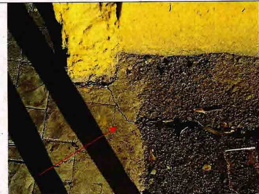
Fotografía N°9 - “Diseño y construcción de áreas verdes en la comuna de Rancagua” – OT N°12 “Mejoramiento espacio público, media luna monumental”. Fisura en pavimento.
