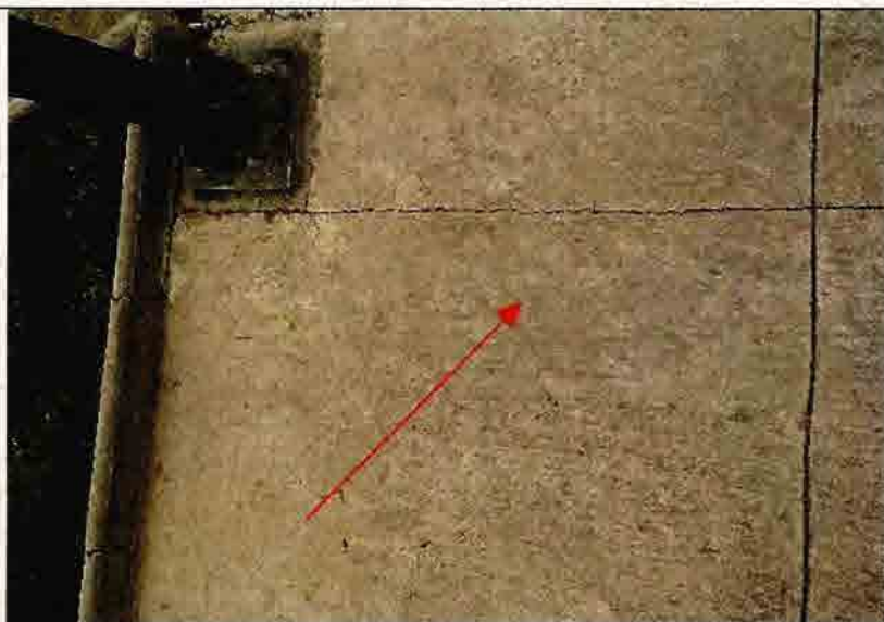
Fotografía N°35 - "Diseño y construcción de áreas verdes en la comuna de Rancagua" – OT N°42 "Mejoramiento área verde av. Miguel Ramírez esquina calle la Araucana": Cortes defectuosos en pavimento.
