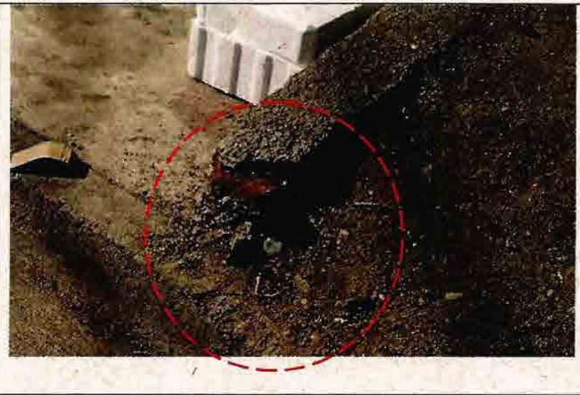
Fotografía N°50 - "Diseño y construcción de áreas verdes en la comuna de Rancagua" - "Radier base para punto limpio parque comunal": Muro de H.A se ejecutó en ladrillo.
