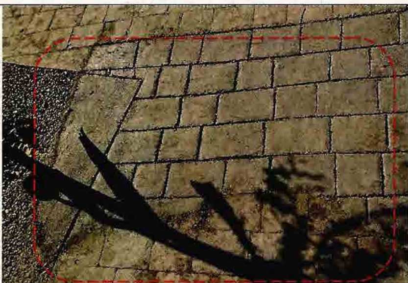
Fotografía N°37 - "Diseño y construcción de áreas verdes en la comuna de Rancagua" – OT N°1 "Mejoramiento bandejón lateral avenida Cachapoal": Deficiente reparación de pavimento y alcorque.
