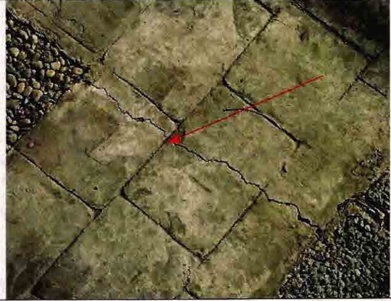
Fotografía N°6 – “Diseño y construcción de áreas verdes en la comuna de Rancagua” – OT N°1 “Mejoramiento bandejón lateral avenida Cachapoal”: Fisura en pavimento.
