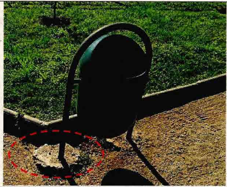
Fotografía N°48 - "Diseño y construcción de áreas verdes en la comuna de Rancagua" – OT N°10 "Mejoramiento área verde villa don mateo, santa Cecilia entre viña del mar y los fresnos". Basurero con base a la vista y suelto.
