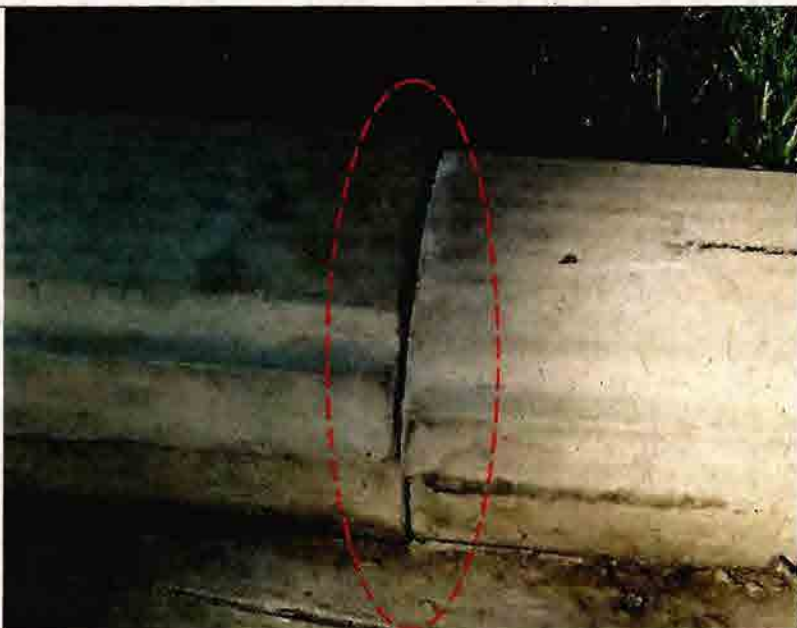
Fotografía N°25 -“Diseño y construcción de áreas verdes en la comuna de Rancagua” – OT N°1 “Mejoramiento bandejón lateral avenida Cachapoal”: Deficiente unión y terminación de bordillo de hormigón.
