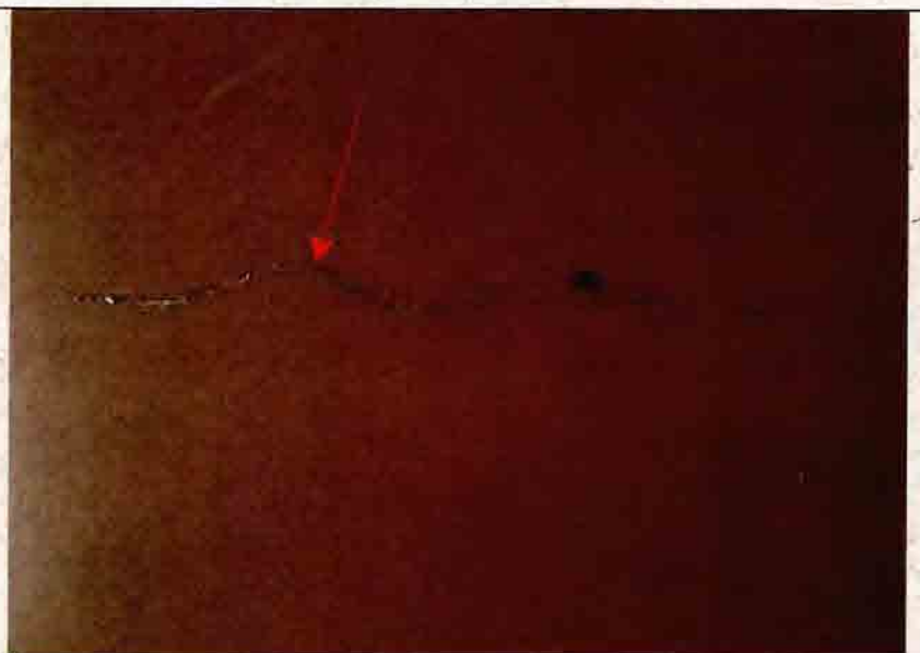
Fotografía N°15- "Construcción Polideportivo Parque Lourdes". Fisuras en pavimento vinílico del recinto N°1 área de juegos.
