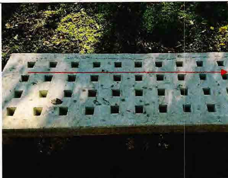
Fotografía N°45 - "Diseño y construcción de áreas verdes en la comuna de Rancagua" – OT N°6 "Provisión e instalación de escaños y basureros en diversos puntos de la comuna": Escaños con fisuras.
