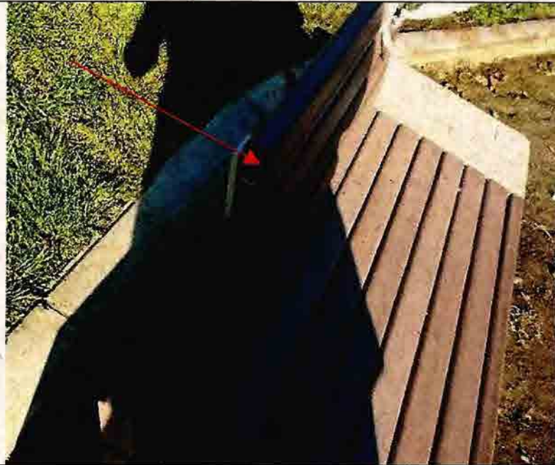
Fotografía N°47 - "Diseño y construcción de áreas verdes en la comuna de Rancagua" – OT N°11 "Provisión e instalación de escaños de polimadera, sector centro": Escaño en mal estado.
