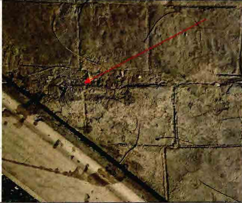
Fotografía N°1 – “Diseño y construcción de áreas verdes en la comuna de Rancagua” – OT N°1 “Mejoramiento bandejón lateral avenida Cachapoal”: Fisura en pavimento.
