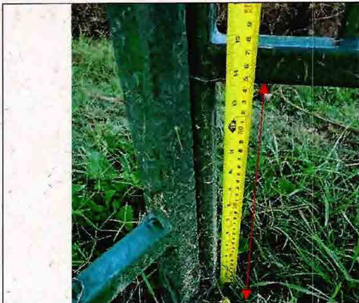
Fotografía N°41 - "Diseño y const. de áreas verdes en la comuna de Rgua" – OT N°27 "Instalación valla peatonal para cierre borde canal calle Sta Cecilia": Altura irregular que permite paso de niños.
