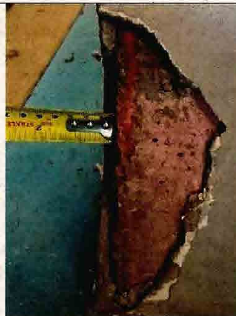
Fotografía N°24-“Construcción Polideportivo Parque Lourdes”. Desprendimiento de revestimiento en base de pilares recinto N°1 área de juegos.
