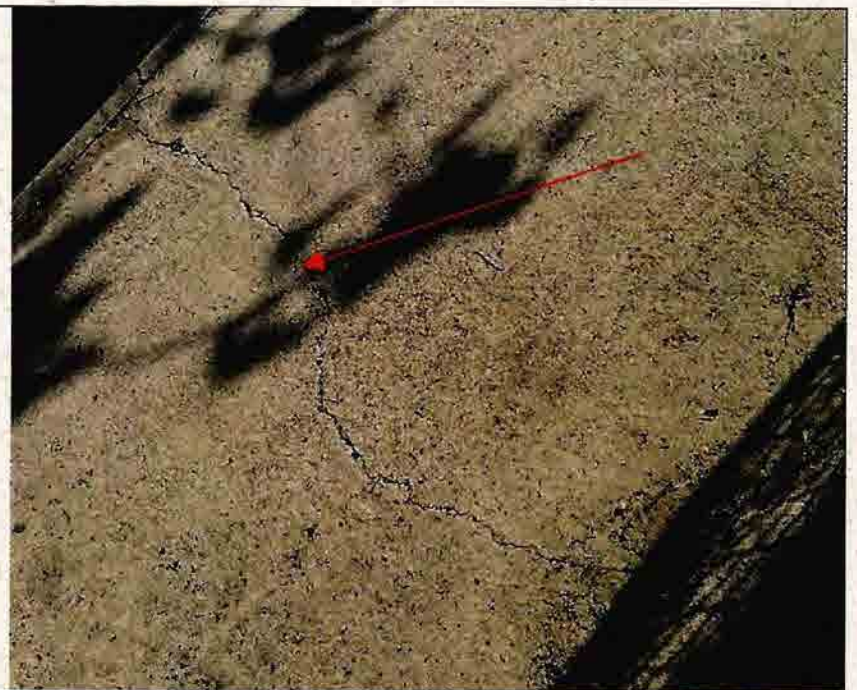
Fotografía N°12 - "Diseño y construcción de áreas verdes en la comuna de Rancagua" – OT N°19 "Mejoramiento multicancha y área verde sector el Libertador". Fisura radier.
