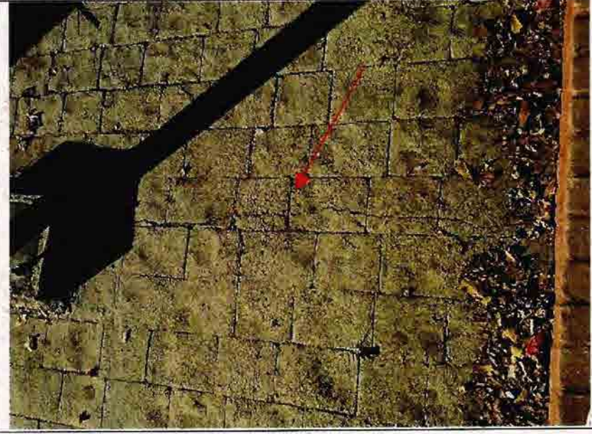
Fotografía N°8 - “Diseño y construcción de áreas verdes en la comuna de Rancagua” – OT N°12 “Mejoramiento espacio público, media luna monumental”. Fisura en pavimento.
