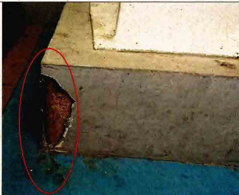
Fotografía N°23-“Construcción Polideportivo Parque Lourdes”. Desprendimiento de revestimiento en base de pilares recinto N°1 área de juegos.
