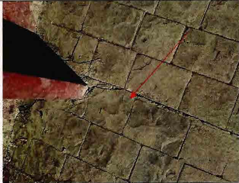
Fotografía N°5 – “Diseño y construcción de áreas verdes en la comuna de Rancagua” – OT N°1 “Mejoramiento bandejón lateral avenida Cachapoal”: Fisura en pavimento.
