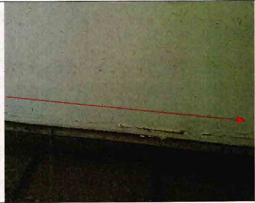
Fotografía N°18-"Construcción Polideportivo Parque Lourdes". Fisura en el recinto N°20 kitchenette.
