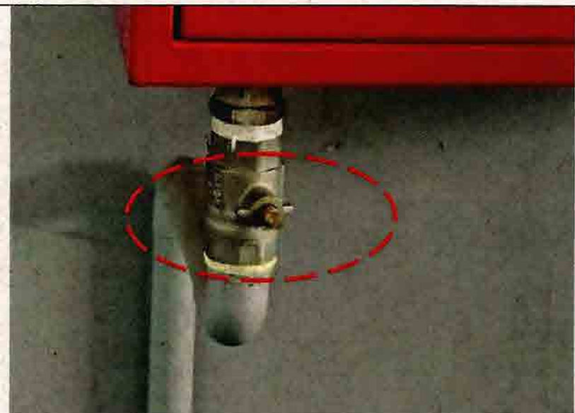
Fotografía N°28-“Construcción Polideportivo Parque Lourdes”. Falta de llave de paso en red húmeda del recinto N°1 área de juegos.
