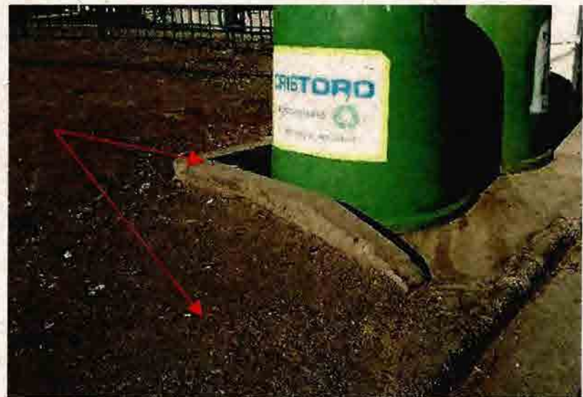
Fotografía N°52 - "Diseño y construcción de áreas verdes en la comuna de Rancagua" – OT N°35 "Radier base para campana de reciclaje": No se advirtió ejecución de maicillo.
