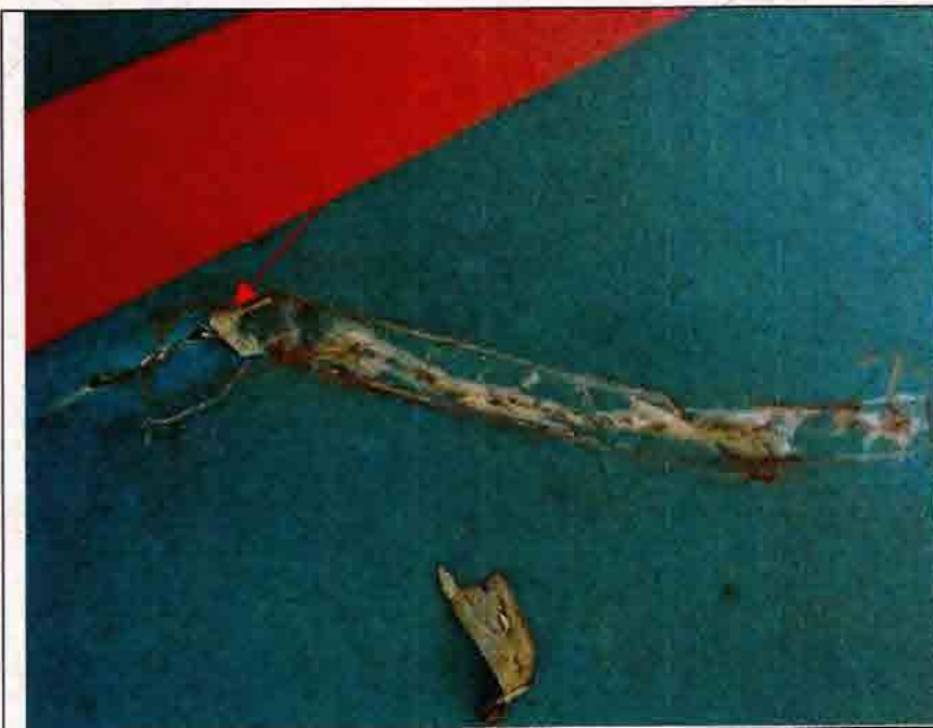
Fotografía N°17-"Construcción Polideportivo Parque Lourdes". Fisuras en pavimento vinílico del recinto N°1 área de juegos.
