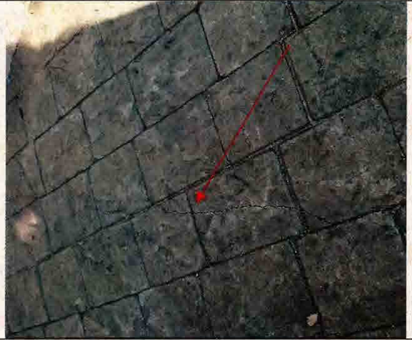
Fotografía N°2 – “Diseño y construcción de áreas verdes en la comuna de Rancagua” – OT N°1 “Mejoramiento bandejón lateral avenida Cachapoal”: Fisura en pavimento.
