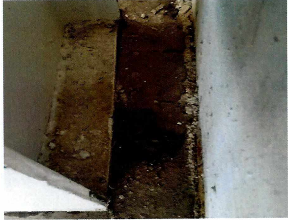
Fotografía N°56 - 12/05/2015: Pilar metálico sin anclaje a fundación ejecutada en la intersección de los ejes A8 y 19.
