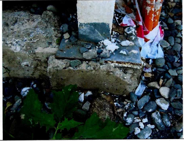
Fotografía N°26 - 13/05/15: Vista de defecto constructivo en la intersección de ejes A1 y 7a, de la planta de arquitectura, versión N°2, de 7 de febrero de 2013, del P.E.N°266, de 2013.
