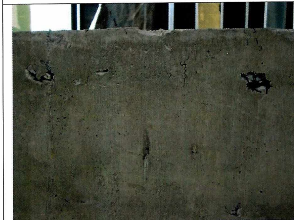
Fotografía N°27 - 13/05/15: Separadores a la vista entre ejes A5-A4 y 17-20 de la planta de arquitectura, versión N°2, de 7 de febrero de 2013, del P.E.N°266, de 2013.
