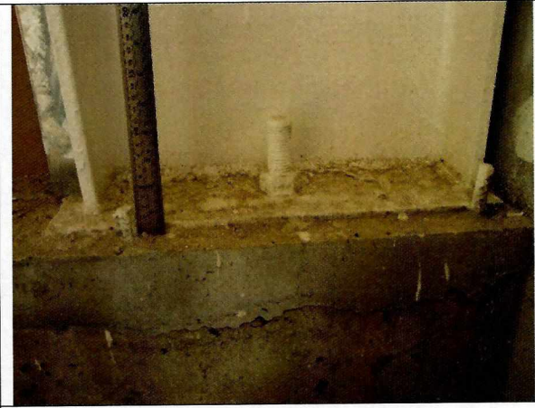
Fotografía N°30 - 12/05/15: Elemento a la vista entre los ejes 17 y A8, de la planta de fundaciones Plano N°10151-G-07.
