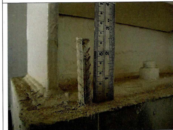
Fotografía N°29 - 12/05/15: Enfieradura a la vista entre los ejes 11 y A8, de la planta de fundaciones Plano N°10151-G-07.
