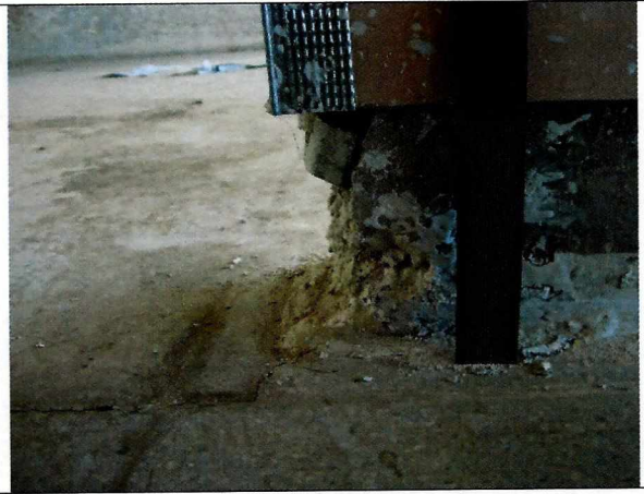
Fotografía N°20 - 13/05/15: Desprendimiento de material en eje B3, entre ejes 9 y 6b, de la planta de arquitectura, versión N°2, de 7 de febrero de 2013, del P.E.N°266, de 2013.
