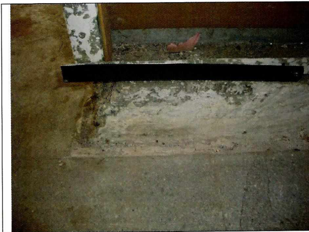
Fotografía N°19 - 13/05/15: Desprendimiento de material en eje B3, entre ejes 6b y 6a, de la planta de arquitectura, versión N°2, de 7 de febrero de 2013, del P.E.N°266, de 2013.
