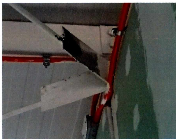
Fotografía N°50 - 13/05/2015: Vista de trabajos posteriores a la pintura en recinto de baños y camarines.
