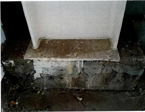
Fotografía N°55 - 12/05/2015: Pilar metálico desprovisto de anclaje a la fundación y con pletina desplazada del eje, en la intersección de los ejes A8 y eje 19.
