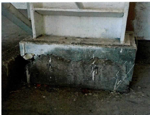
Fotografía N°53 - 12/05/2015: Pilar metálico desprovisto de anclaje a la fundación emplazada en la intersección de los ejes A8 y 11.
