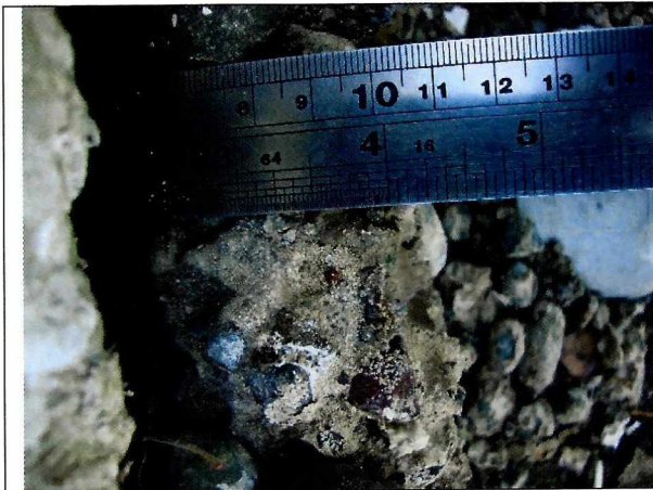
Fotografía N°25 - 13/05/15: Detalle de la profundidad de 6 cms. de defecto constructivo en intersección de ejes A1 y 10, de la planta de arquitectura, versión N°2, de 7 de febrero de 2013, del P.E.N°266, de 2013.
