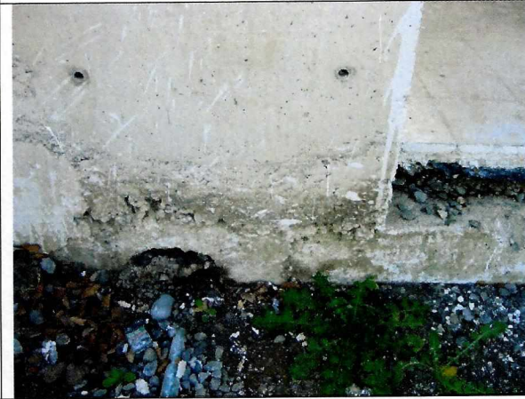
Fotografía N°24 - 13/05/15: Defecto constructivo en intersección de ejes A1 y 10, de la planta de arquitectura, versión N°2, de 7 de febrero de 2013, del P.E.N°266, de 2013.
