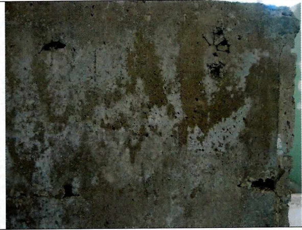
Fotografía N°28 - 13/05/15: Separadores a la vista entre los ejes A5-A4 y 15-17 de la planta de arquitectura, versión N°2, de 7 de febrero de 2013, del P.E.N°266, de 2013.
