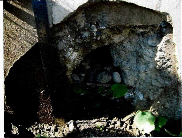
Fotografía N°22 - 13/05/15: Detalle de defecto constructivo que supera los 30 cms., en eje 20, entre ejes A5 y A1, de la planta de arquitectura, versión N°2, de 7 de febrero de 2013, del P.E.N°266, de 2013.
