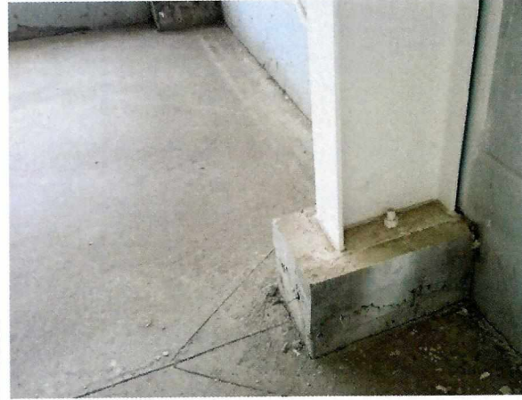
Fotografía N°58 - 12/05/2015: Detalle de juntas de dilatación en ángulos inferiores a 90°, en recinto de uso multiple, en ejes A8 con 18.
