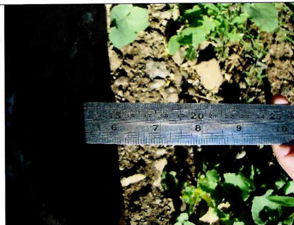
Fotografía N°23 - 13/05/15: Ilustración de la profundidad de 10 cms. de defecto constructivo en eje 20, entre ejes A5 y A1, de la planta de arquitectura, versión N°2, de 7 de febrero de 2013, del P.E.N°266, de 2013.
