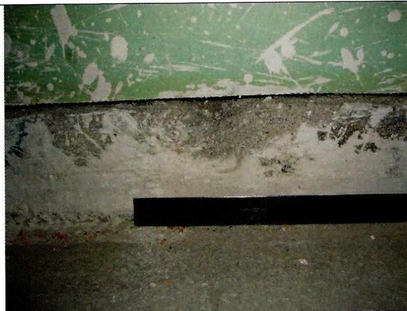
Fotografía N°21 - 13/05/15: Desprendimiento de material en eje B4, entre ejes 9 y 6b de la planta de arquitectura, versión N°2, de 7 de febrero de 2013, del P.E.N°266, de 2013.
