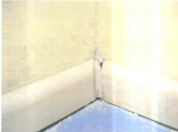
Fotografía N°24: Vista de encuentro de guardapolvo.
