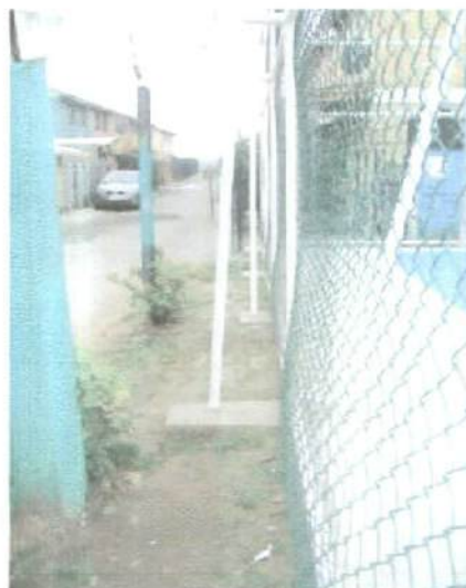
Fotografía N°19: Vista de la colocación de la malla metálica.
