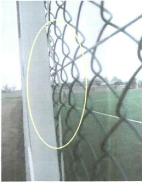
Fotografía N° 2: Detalle de la fijación ejecutada por el contratista.
