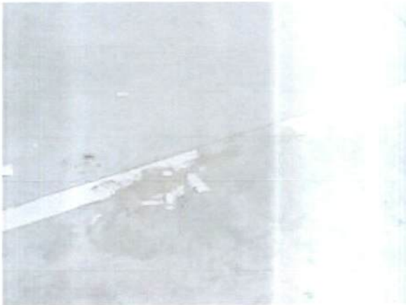
Fotografía N° 87: Detalle del desprendimiento de la línea blanca de demarcación.
