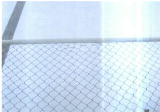
Fotografía N°14: Vista superior del cierre.
