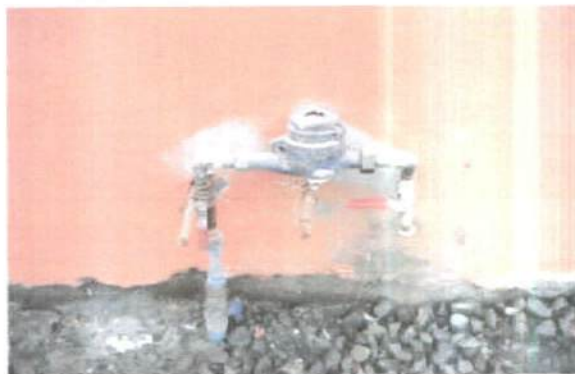
Fotografía N°42: Vista de muro sin pintura alrededor del medidor
