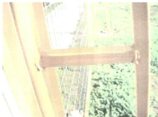
Fotografía N° 62: Detalle de elemento metálico con desprendimiento de pintura y corroído.
