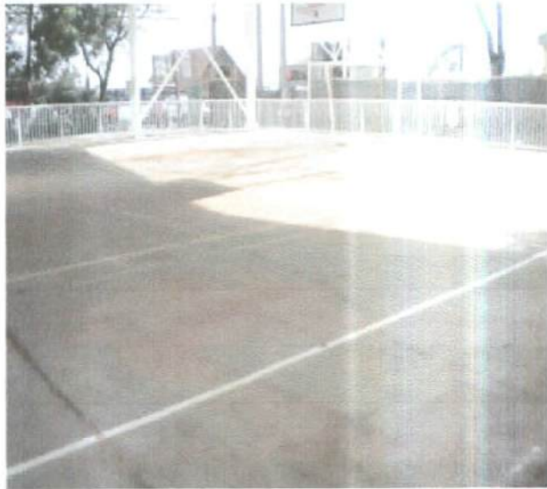
Fotografía N°47: Vista de la losa existente.
