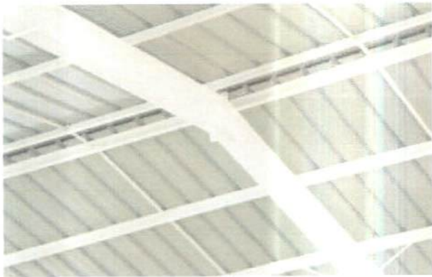
Fotografía N°45: Vista de encuentro de vigas.
