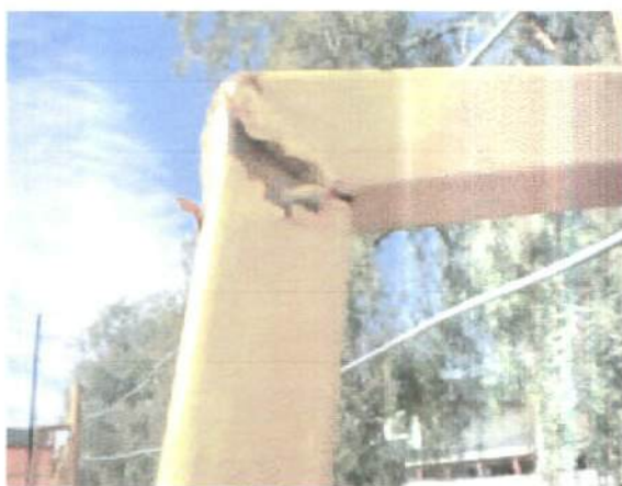
Fotografía N° 62: Detalle de elemento metálico con desprendimiento de pintura y corroído.
